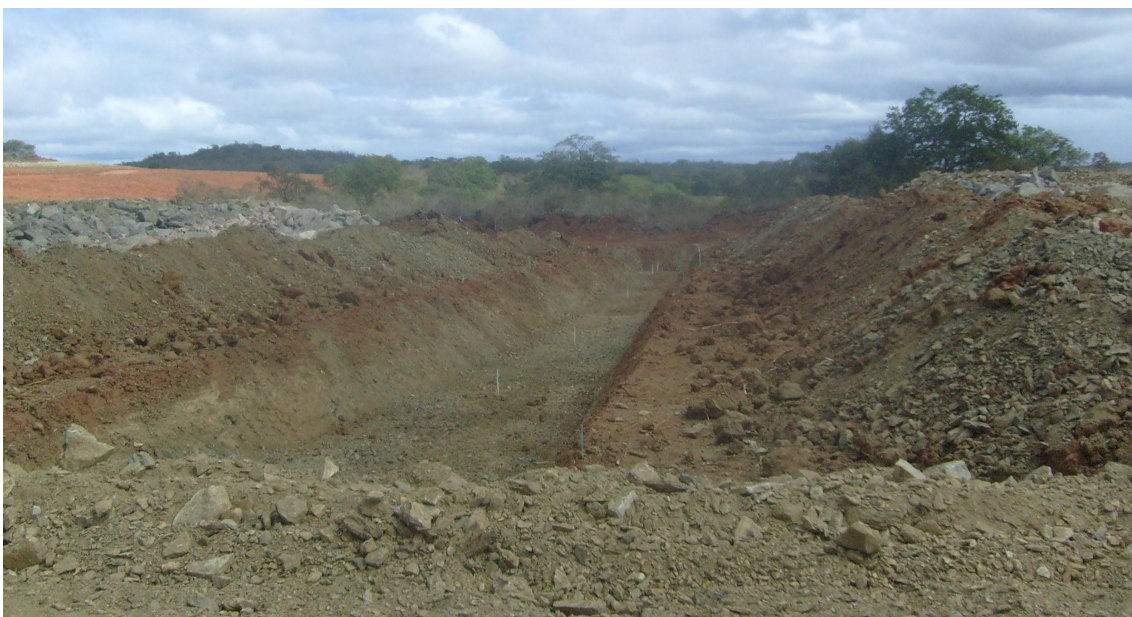
Foto 4: Detalhe da escavação do canal
