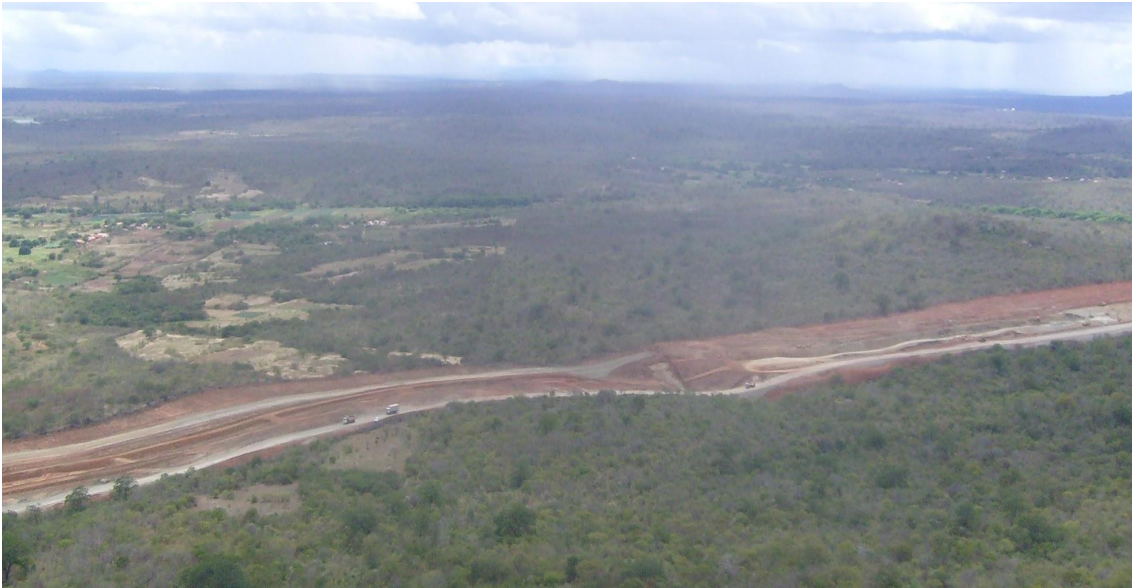
Foto 3: Visão de parte do Canal da transposição no território de Santana
