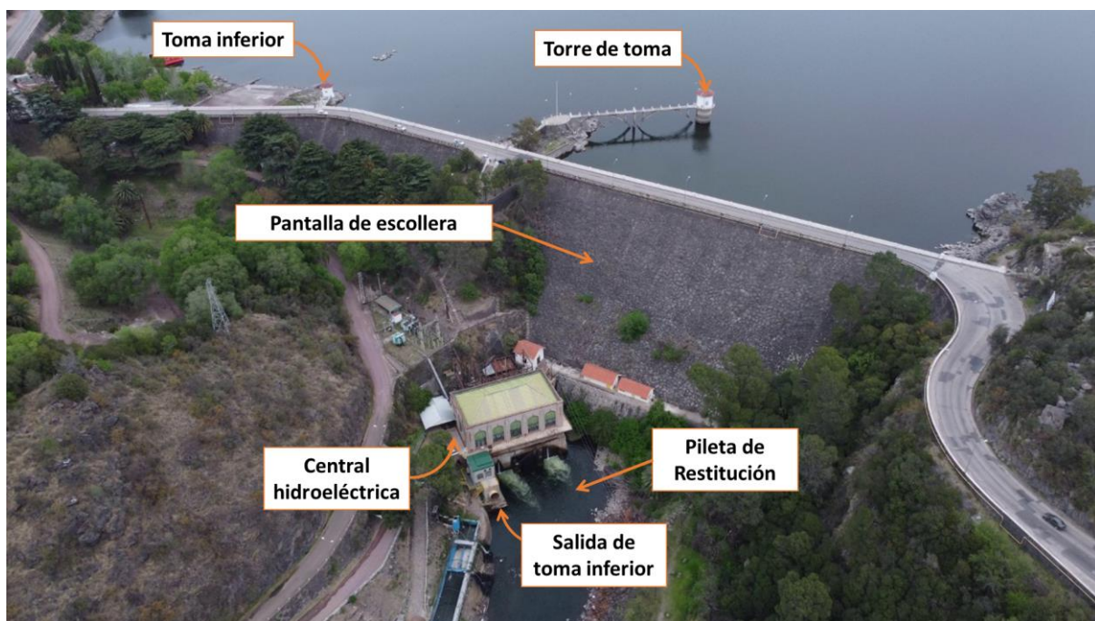
Figura 12: Componentes del Sistema Hidroeléctrico Fitz Simon
