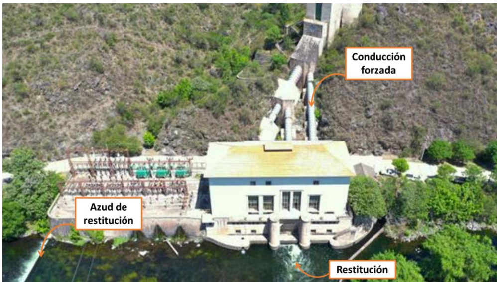
Figura 14. Componentes del Sistema Hidroeléctrico Cassaffousth
