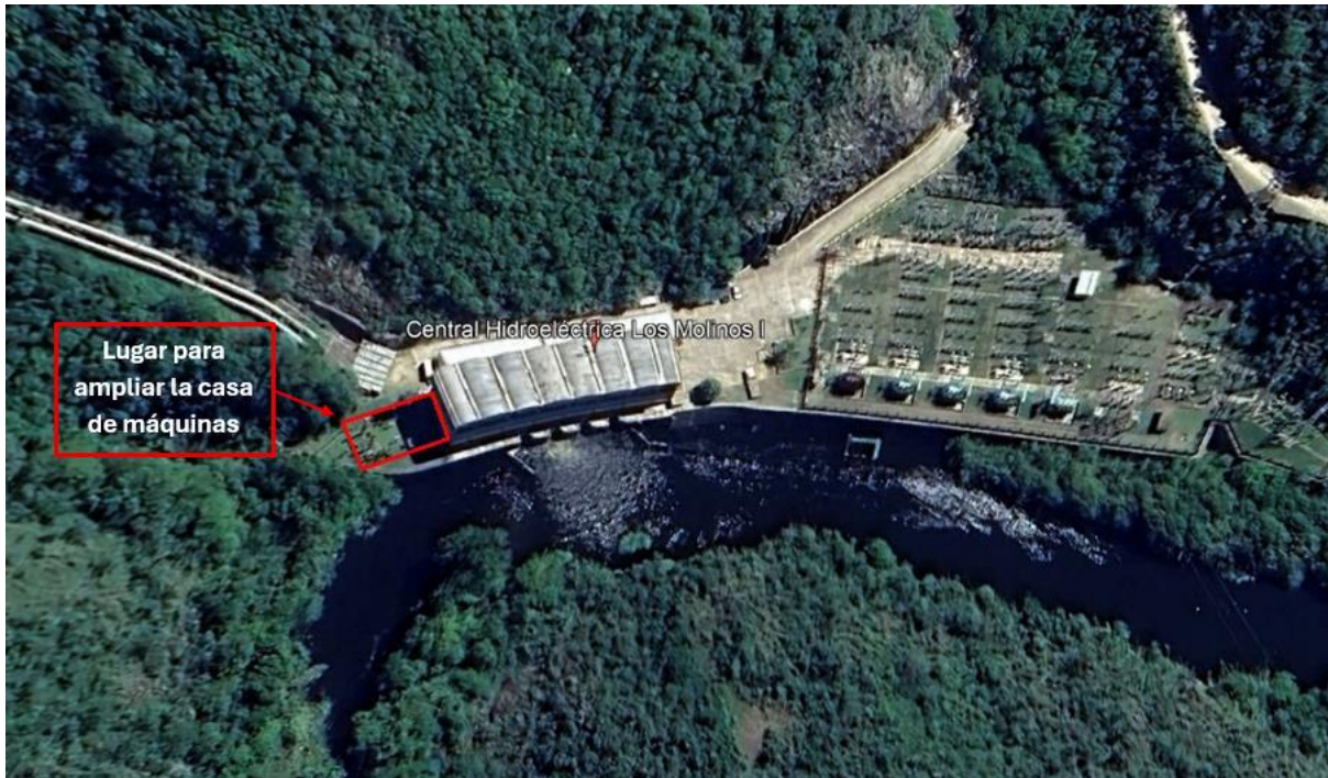
Figura 10: Lugar para la ampliación de la casa de máquinas Central Los Molinos I
